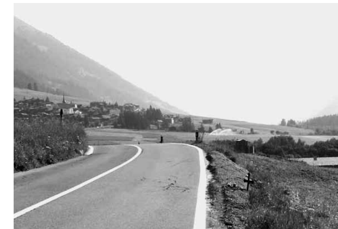
Zwei Wochen nach dem Unfall: Jetzt sind die Seitenlinien vorschriftsmässig gezogen. Der Seitenrand ist grasfrei und das Strassenbord mit Füllmaterial angehoben.
