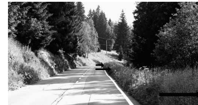
Kantonsstrasse zwischen Fürgangen und Niederwald am 2. Juli: Die Seitenlinie ist gezogen, aber das Gras ist noch höher geworden, so dass die Pfosten nicht mehr sichtbar sind und das Licht nicht mehr reflektiert wird.
